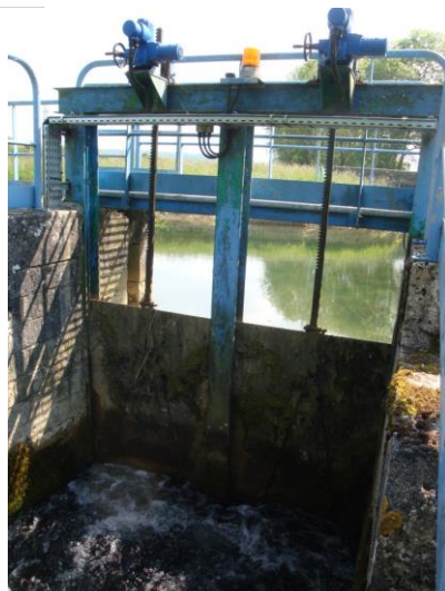
Figure 6 : Vannage en rive droite
