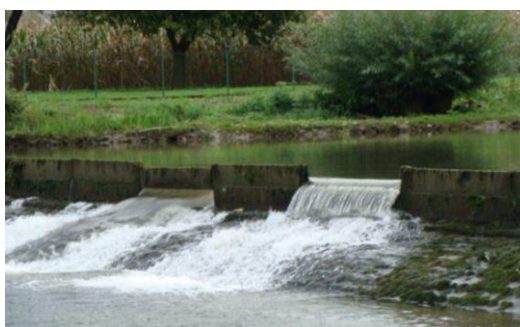
Figure 8 : Etat d'ouverture intermédiaire observé lors de l'inspection subaquatique
